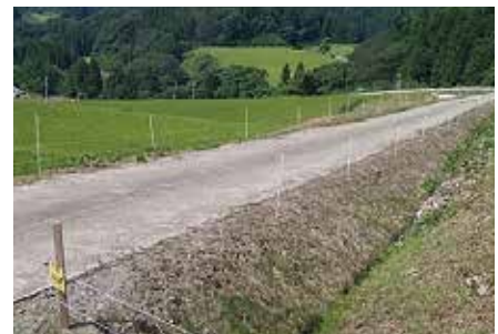
電気柵による侵入防止の取組
